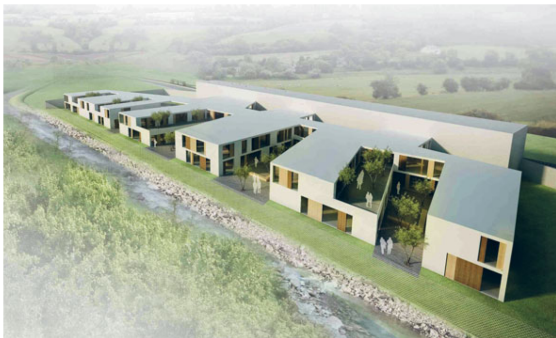
Neues Schubhaftzentrum in Vordernberg. Für 20 Mio. Euro wurde der Bau errichtet.
